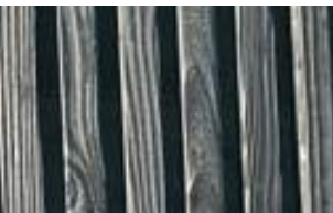
Entre 3 et 7 ans après installation
