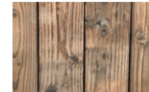
Entre 3 et 7 ans après installation
