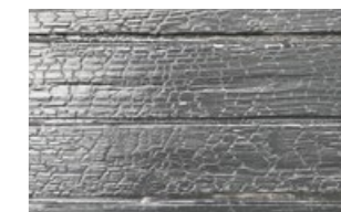
Entre 3 et 7 ans après installation
